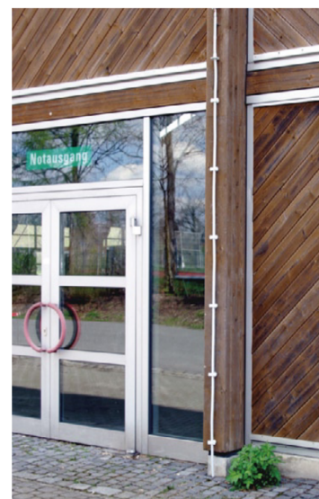
Установка CUI-проводника
